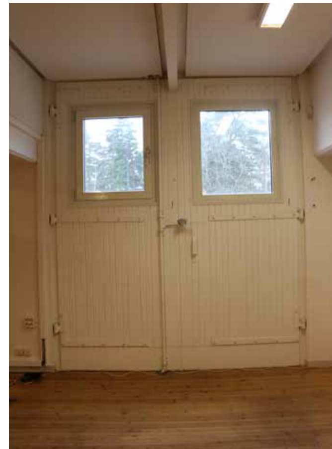
Ursprunglig port och bevarad travers i våning 2.
