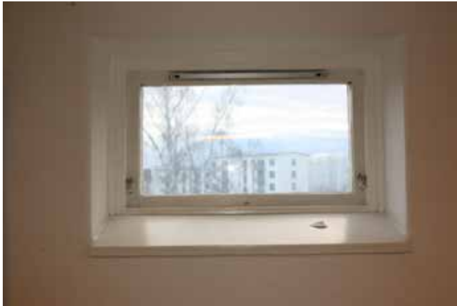
Ursprungliga fönster och fönsterbrädor av trä med ursprungliga fönsterhaspar.
