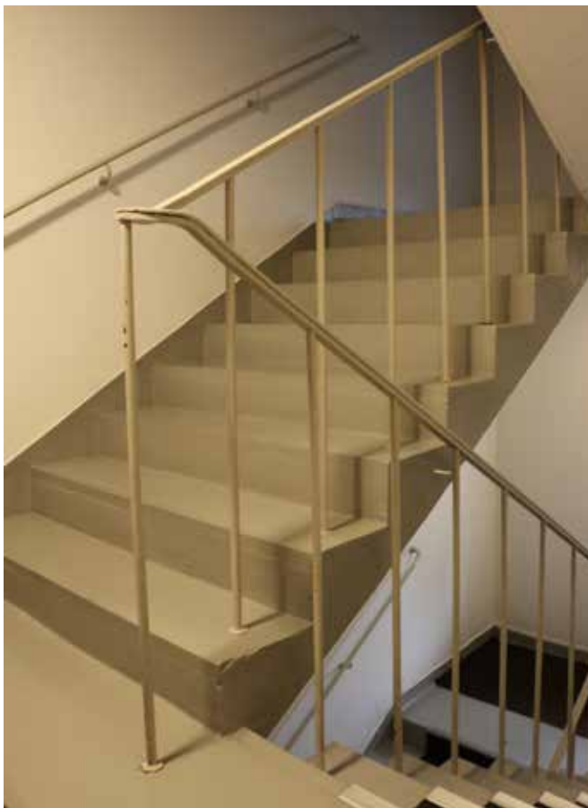
Trapphus med gjutna trappor och smidesräcken.
