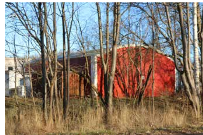
Fastigheten Höjdmätaren 1. Tält över lagerhall.
