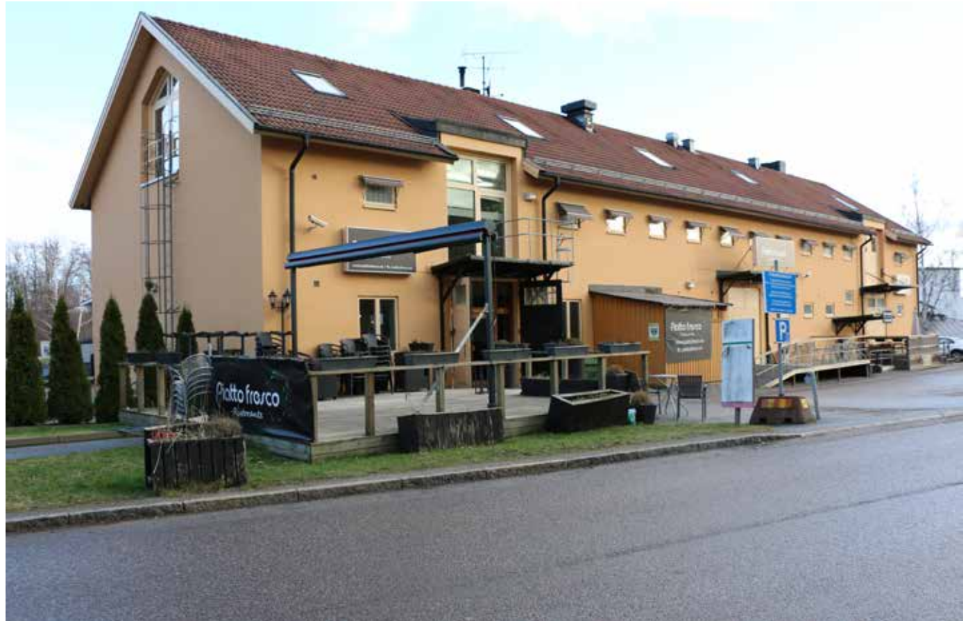
F.d. tygförrådet på fastigheten Fenan 1. Tillägg har utförts på ett mindre varsam sätt.
