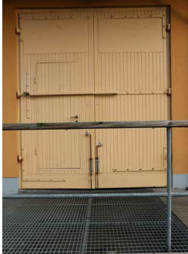
Ursprungliga portar med kraftiga bandgångjärn.
