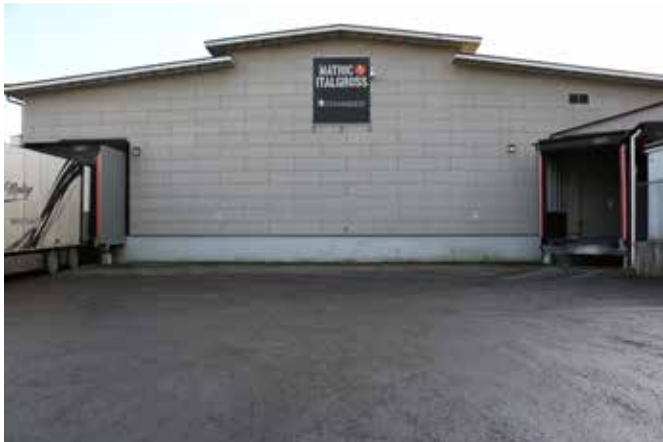
Lagerhall tillbyggt år 2006.
