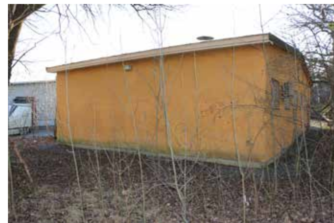
Fordonsförrådet åt norr.
