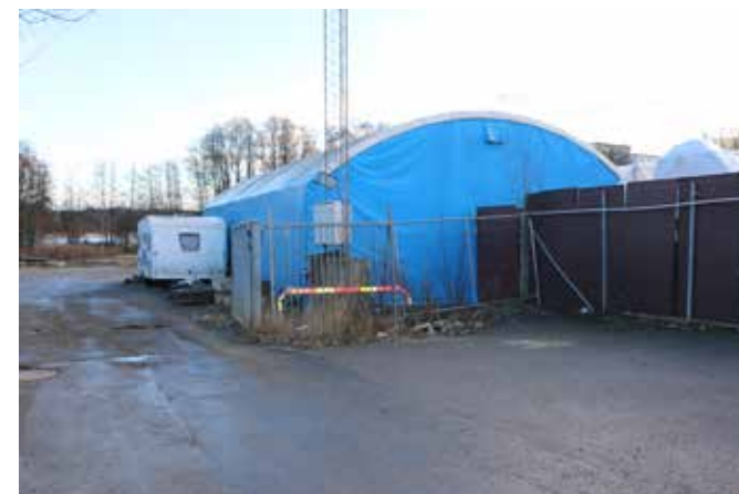
Fastigheten Höjdmätaren 1. Tält över lagerhall.
