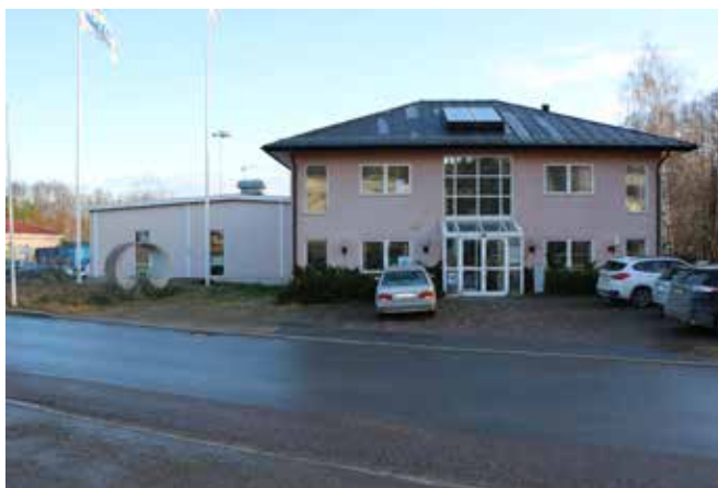
Fastigheten Flygkompassen 1. Kontor- och industbyggnad uppförd under 1990-talet.
