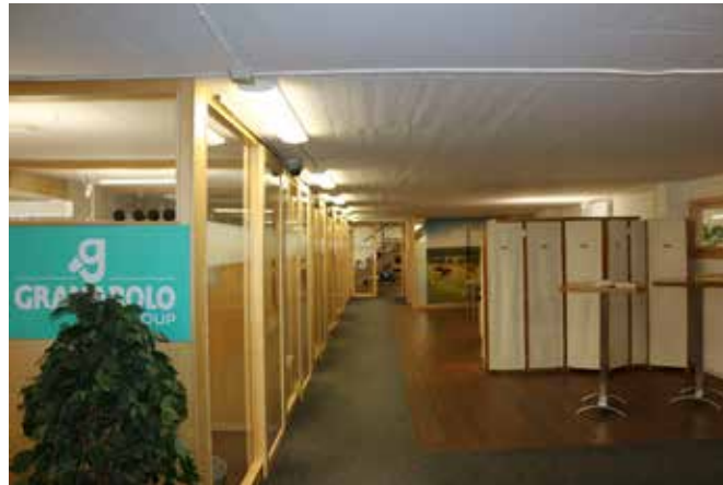
Utrymme med brädgolv och brädgjutna tak.
