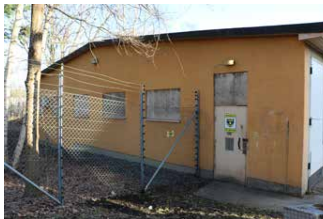
Fordonsförrådet mot väster. Fönster och dörrens överljus har täckts.
