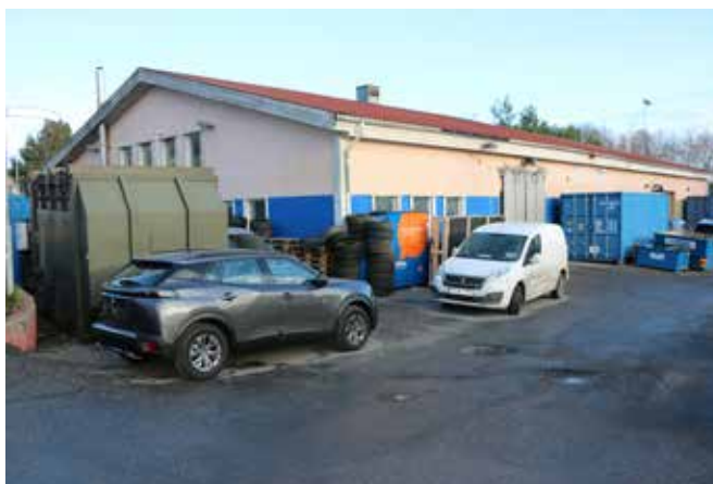
Fastigheten Stjärnmotorn 1 och 2. Industribyggnad uppförd år 1985 med tillbyggnad från år 1993.
